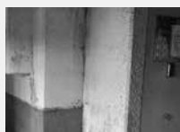
外壁：石綿含有仕上げ塗材(塗料)
