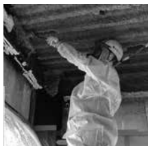
外壁：石綿含有仕上げ塗材(塗料)
